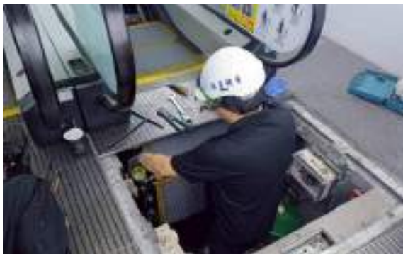
圖2.6.17-總館電梯、電扶梯零配件改善更新
