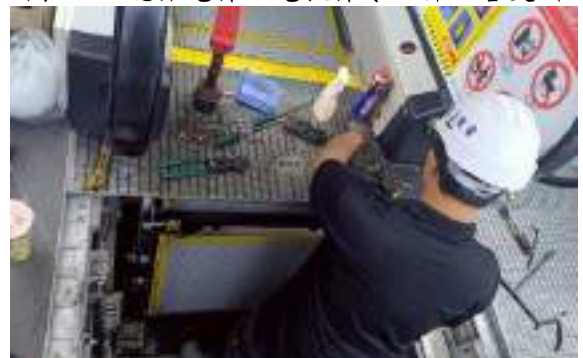
圖2.6.20-總館電梯、電扶梯零配件改善更新
