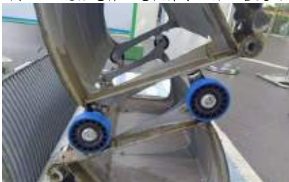
圖2.6.19-總館電梯、電扶梯零配件改善更新
