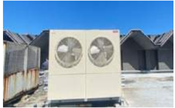
圖2.6.14-汐止大同分館陳列館空調冰水主機汰換
