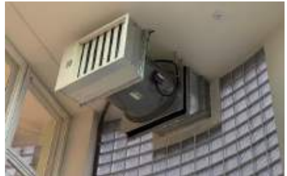
圖2.6.16-板橋四維分館消防設備改善
