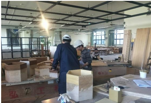
圖4-15閱讀角施工前
