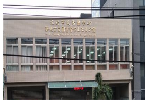
圖2-146：汐止江北分館建物整修後
