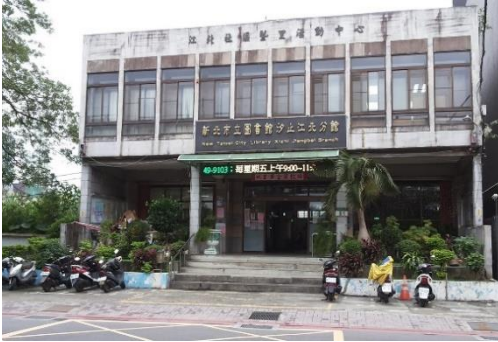
圖2-145：汐止江北分館建物整修前
