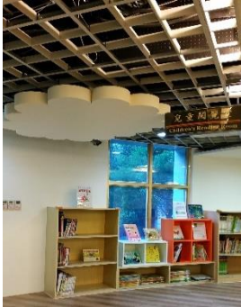
圖2-213：兒童閱覽區天花板新增吸音隔板
