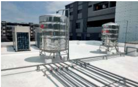
圖4.4.3- 更換老舊空調外機及水塔設備
