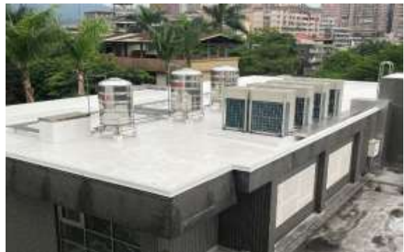
圖4.4.4- 屋頂防水隔熱處理
