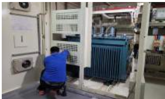
圖2.6.15- 總館高壓變壓器汰換
