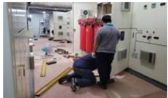
圖2.6.16- 總館高壓變壓器汰換
