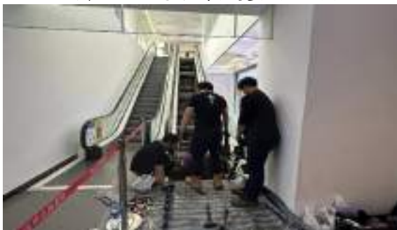
圖2.6.17- 總館電扶梯踏板鍊條更新
